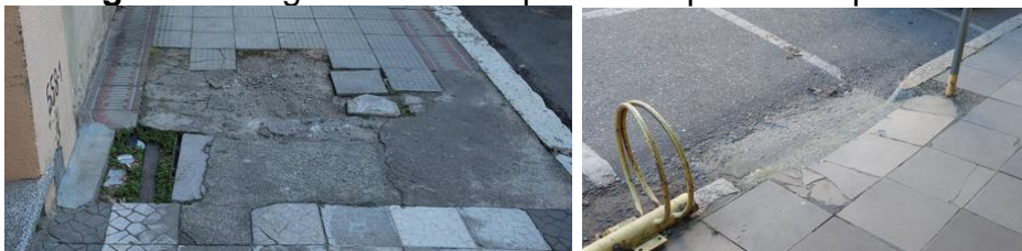
Figura 1: Irregularidades no piso e rampas inadequadas.
