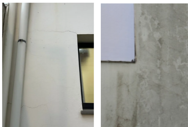
Figura 2: Fissuras externas. Fonte: Acervo das autoras, 2025.
