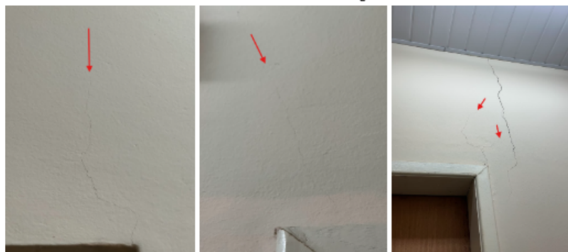
Figura 1: Fissuras internas. Fonte: Acervo das autoras, 2025.
