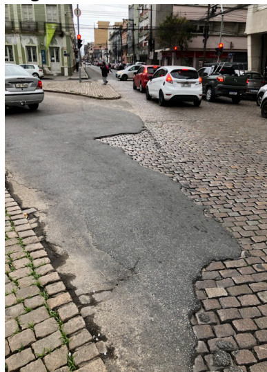
Figura 3: Pavimento Misto
