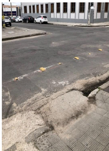
Figura 1: Rampa de acessibilidade em más condições
