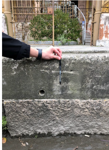
Figura 2: Altura do meio fio
