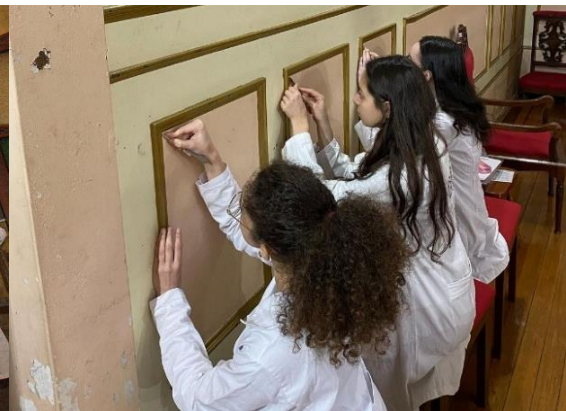
Figura 4 - Abertura de janelas de prospecção nas paredes da Igreja do Porto. Fonte: LACORPI, 2023.
