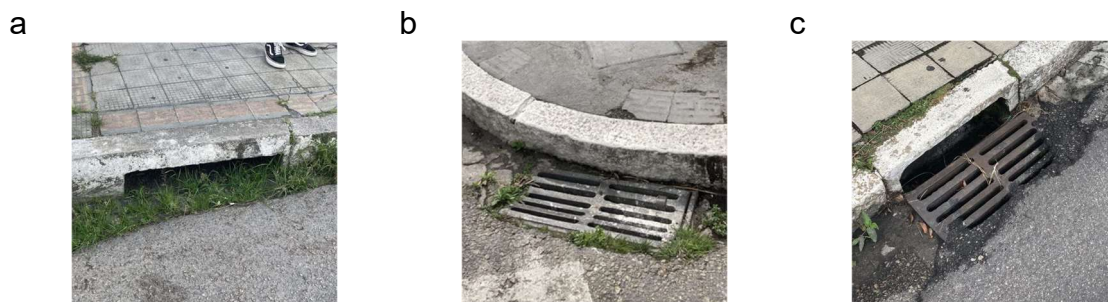
Figura 1 - Exemplos de tipologias de bocas-de-lobo encontradas na BEU Canalete da Argolo, sendo (a) simples, (b) grelha, (c) combinada
