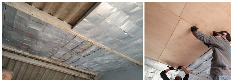
Figuras 6 e 7: Processo de fixação dos dispositivos climáticos no telhado. Fonte: Acervo dos autores, 2021.
