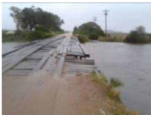
Figura 4. Estrada Costa Doce com bueiros de tubos de concreto danificados e recapagem de compactação do solo danificado, além de valos de drenagem pluvial entupidos em uma extensão de 10 quilômetros e ponte danificada.
