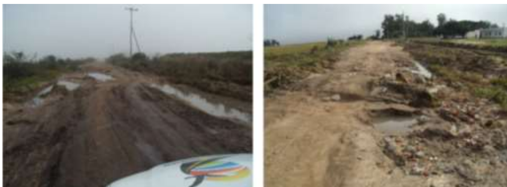
Figura 3. Estrada da Coxilha Grande com cinco bueiros de canos de concreto armado rompidos, recapagem de compactação do solo danificado e valos de escoamento pluvial entupidos em uma extensão de dezoito quilômetros.
