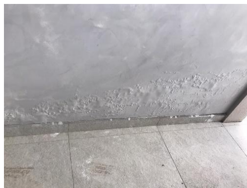
Figura 4 e 5 – Manifestação patológica em garagem.
