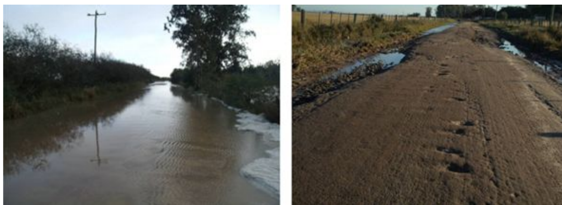
Figuras 2 e 3 - Estrada Coxilha Grande com transbordo da enxurrada, danificando a recapagem de compactação do solo.
