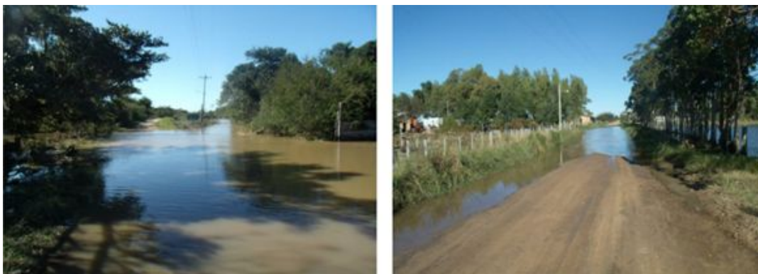
Figura 4 e 5 - Estrada Travessa Maria Gomes com transbordo da enxurrada, danificando a recapagem de compactação do solo, entupimento do escoamento laterais da água e afetando a estrutura da ponte Maria Gomes.
