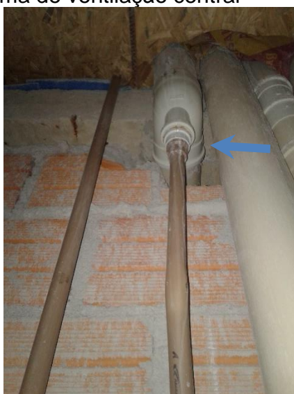
(a) Sistema de drenagem acoplado ao sistema de ventilação
