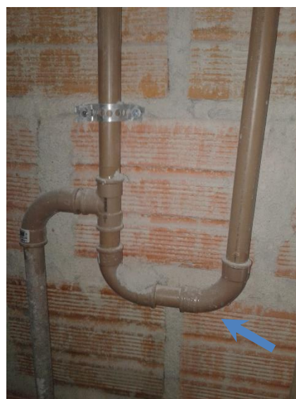
(b) Detalhe do sifão para impedir retorno
