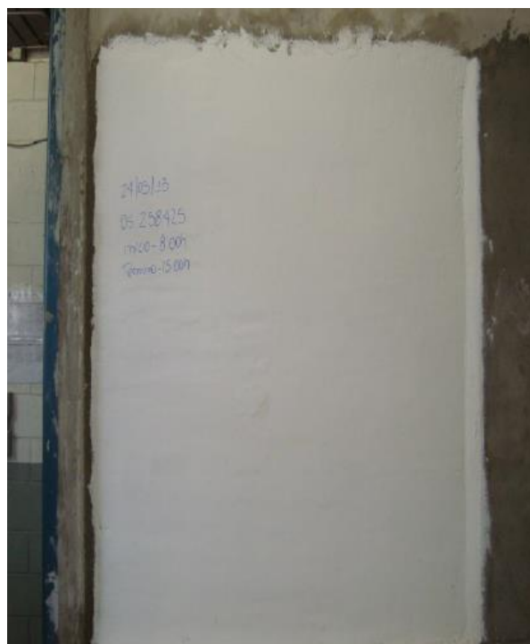
Figura – 2: Lado interno da parede construída com blocos de gesso
