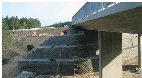
Figura 3 – Aterro com muro de bloco TERRAE. Fonte: TERRAE PROJETOS E CONSULTORIA LTDA (2018).
