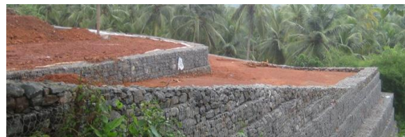
Figura 2 – Muro de gravidade com gabião. Fonte: MACCAFERRI (2018).
