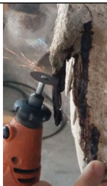
Figura 1: Retirada dos ferros oxidados Fonte: Letícia Alves Pereira, 2017.
