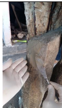
Figura 2: Consolidação da perna Fonte: Lindsay Rocha Taveira, 2017.
