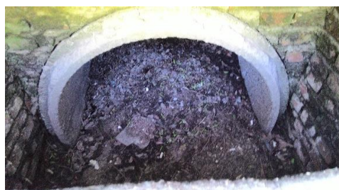
Figura 6: Boca de lobo localizada no canteiro central da Avenida Saldanha Marinho. Fonte: O Próprio Autor.
