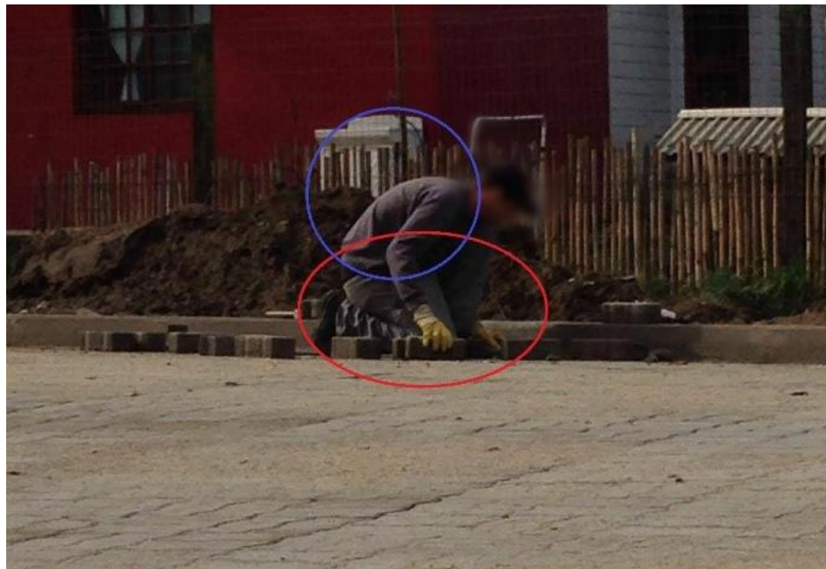
Figura 1 - Trabalhador assentando os blocos de pavimento.
