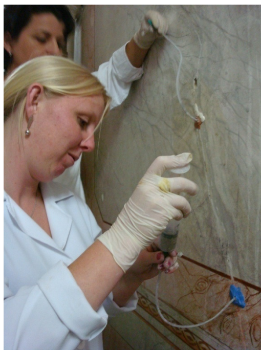
Figura 2 - Injeção de argamassa consolidante em revestimento de alvenaria com acabamento em escariola.
