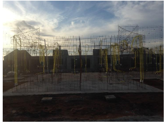
Figura 2 – Armadura principal com eletrodutos
