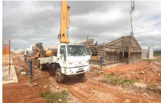
Figura 4 – lançamento do concreto
