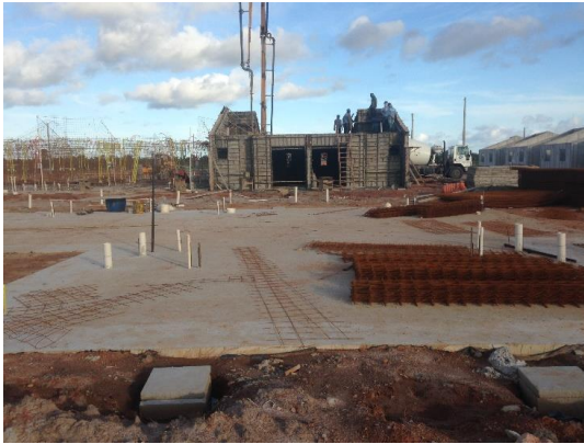
Figura 1 – Fundação em Radier
