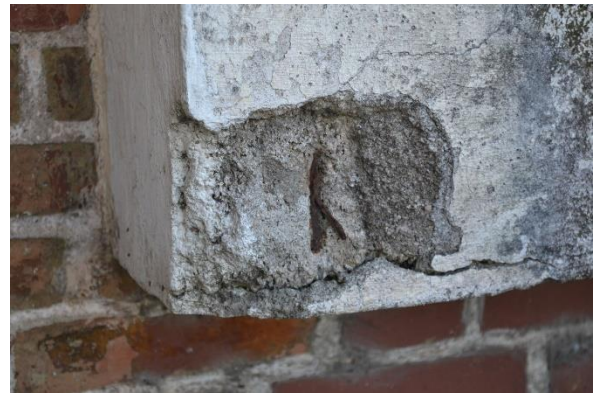
Figura 4 – Descolamento do concreto. Foto da autora.
