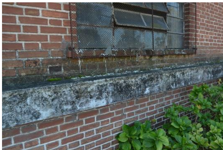
Figura 2 – Sujidade nos elementos de marcação em concreto. Foto da autora.
