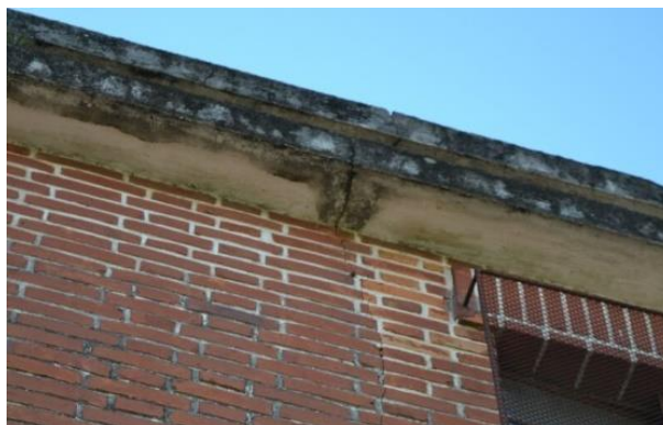
Figura 4 – Trinca na estrutura de concreto armado. Foto da autora.
