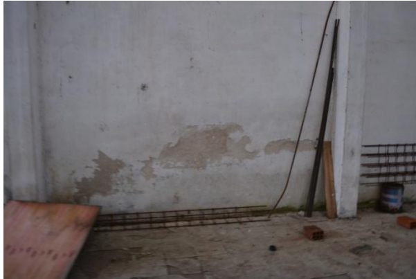
Figura 3 - Esfarelamento do revestimento próximo ao piso. Foto da autora.
