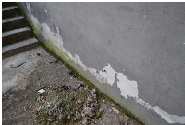
Figura 6: Descolamento da pintura e presença de micro-organismos. Foto da autora.
