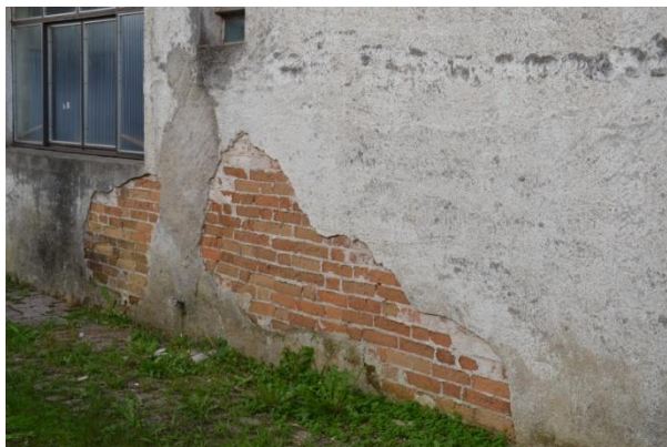
Figura 5: Descolamento do revestimento. Foto da autora.
