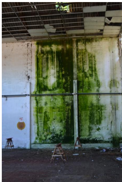
Figura 1 - Mancha de umidade. Foto da autora.
