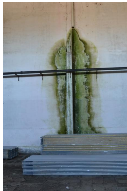
Figura 2 - Mancha de umidade. Foto da autora.
