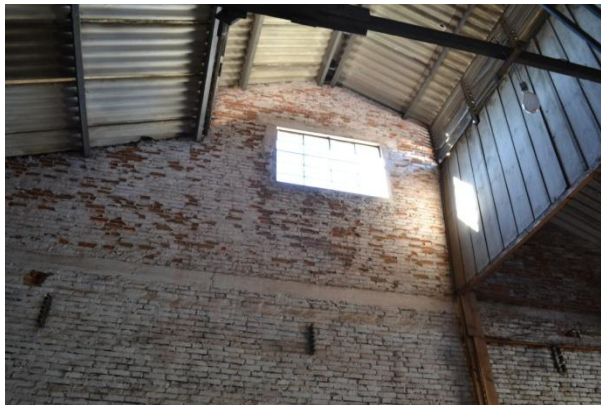
Figura 4 - Esfarelamento do revestimento. Foto da autora.
