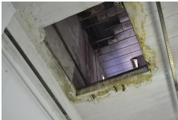
Figura 5 - Manchas de mofo, deterioração do concreto e armadura exposta na laje de concreto. Foto da autora.
