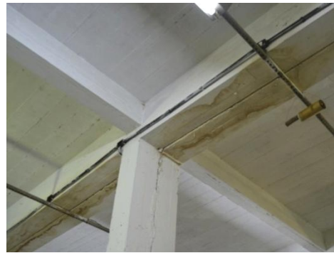
Figura 4 - Manchas de mofo na junta de dilatação da estrutura de concreto. Foto da autora.
