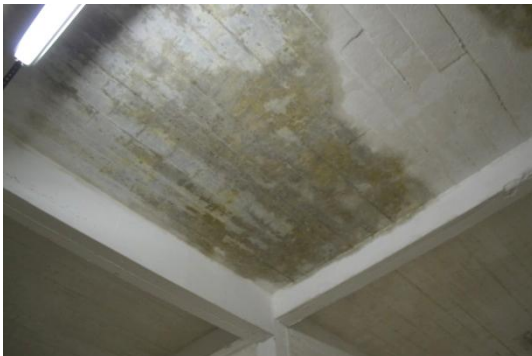
Figura 3 - Manchas de umidade na laje de entrepiso. Foto da autora.
