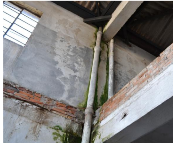
Figura 6 - Manchas de mofo e deterioração do concreto. Foto da autora.
