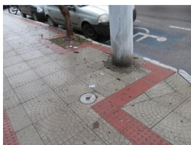
Figura 4. Piso mal instalado, podendo acarretar acidentes. Fonte: Acervo pessoal.
