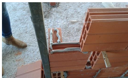
Figura 3 – Racionalização do Sistema de Argamassa.
